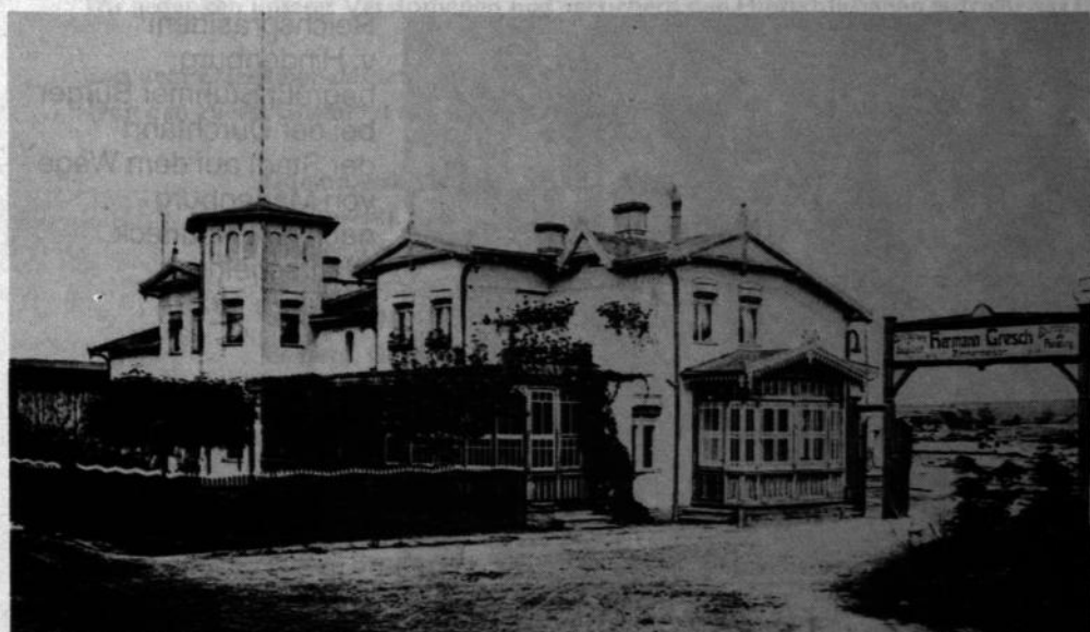
Dampfschneidemühle von H. Gresch, Rehhof. s. S. 8
